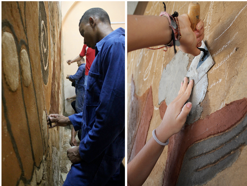
Figura 4. Aplicación de técnica de esgrafiado y estuco de detalles. (Crédito: archivo Pangea Fundación, 2016 - 2017)
