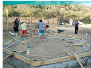
3. construcción de sobrecimiento con hormigón armado
