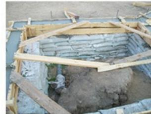
Figura 3. Proceso constructivo y capacitación de la comunidad para la construcción de la fundación.
