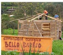
3. montaje de la estructura de techumbre autoportante
