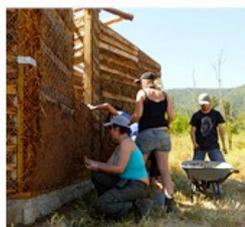
4. revoque de la estructura con una mezcla de tierra
